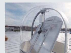
吹き抜けの上部に設置した、GPS太陽光自動追尾装置
